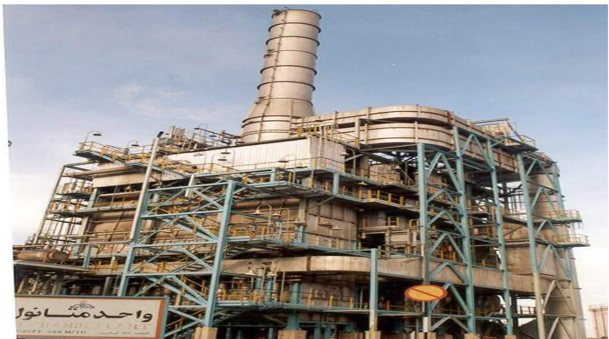
هدف واحد ریفرمینگ<sup>۱</sup> گاز (واحد 22) تبدیل گاز طبیعی که عمدتاً از گاز متان ( $\text{CH}_4$ ) تشکیل می‌شود به گاز سنتز می‌باشد. واکنش شیمیایی در کوره بهسازی بخار (ریفرمینگ) که از 100 تیوب پر شده با کمک کاتالیست نیکل صورت می‌گیرد. قبل از اینکه گاز سنتز به ورودی کمپرسور<sup>۲</sup> در واحد 23 (تبدیل گاز و سنتز متانول) هدایت شود در چندین مرحله خنک می‌گردد. فرآیند ریفرمینگ گاز توسط بخار در هفت زیر سیستم انجام می‌گردد. این زیر سیستم‌ها عبارتند از:
